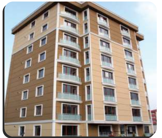
PINAR İNŞAAT - PENDİK
