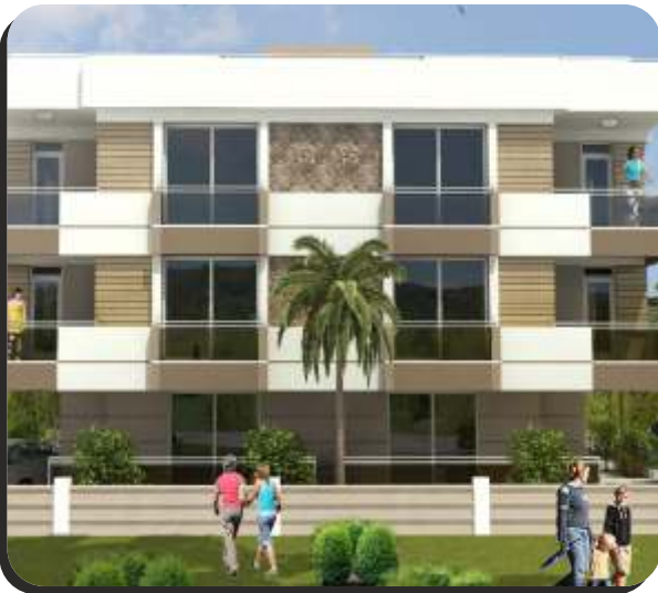
İNCİ İNŞAAT - DARICA
