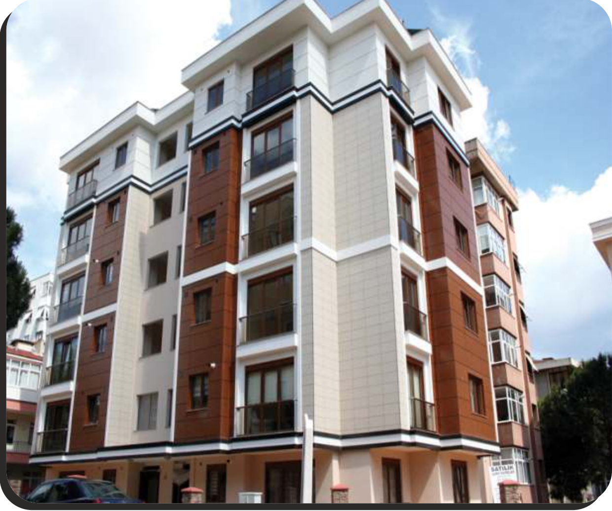
TAYF İNŞAAT - MALTEPE
