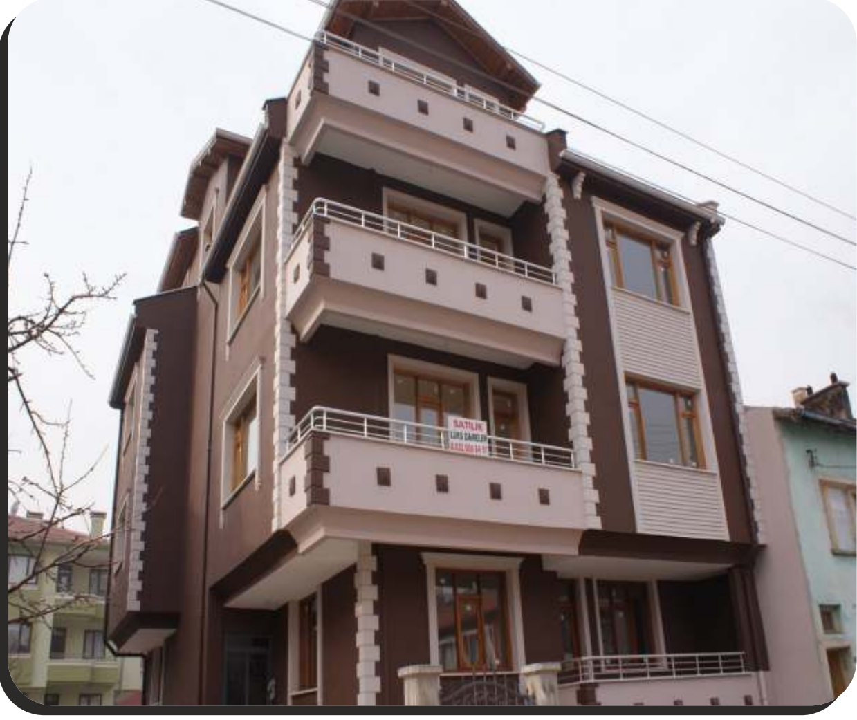
AK BATI İNŞAAT - SAKARYA
